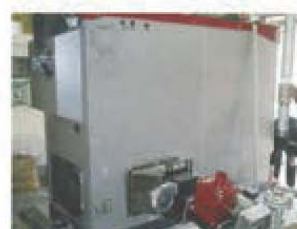
ペレットボイラー
